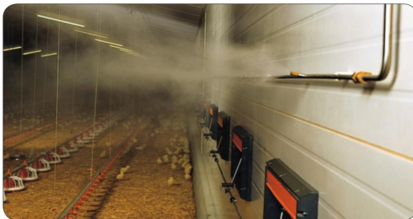
شکل ۱۰- سیستم خنک‌کننده مه‌پاش در داخل آشیانه به منظور تأمین رطوبت
